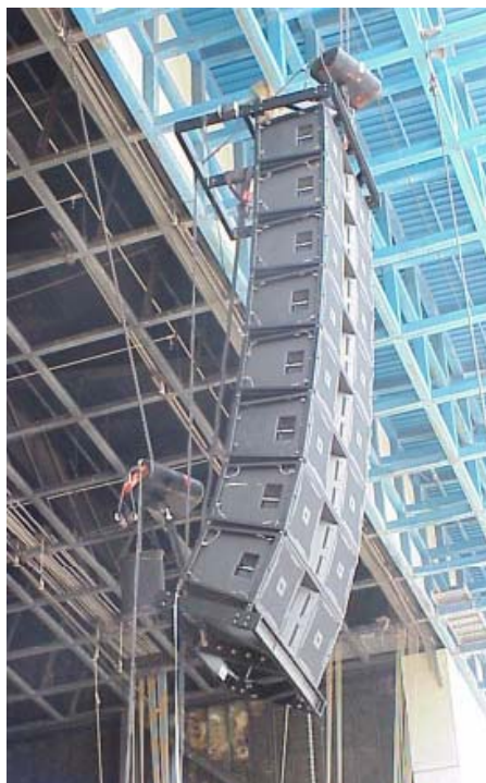
Fig 2. 8 gabinetes formando un arreglo.
