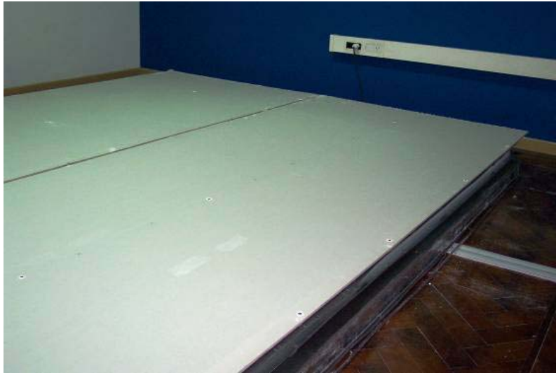
Configuración N° 2: Placa de yeso Knauf revestida un 41,3% con Difusores Marthena .
